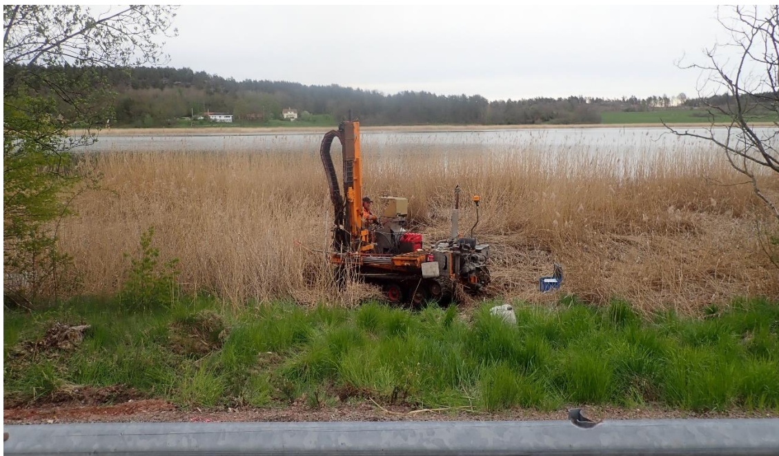
Figur 15. Geoteknisk undersökning vid sektion I.
