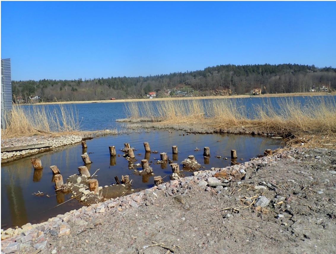
Figur 13. Framschaktad bankpålning längs stranden i området vid sektion G.
