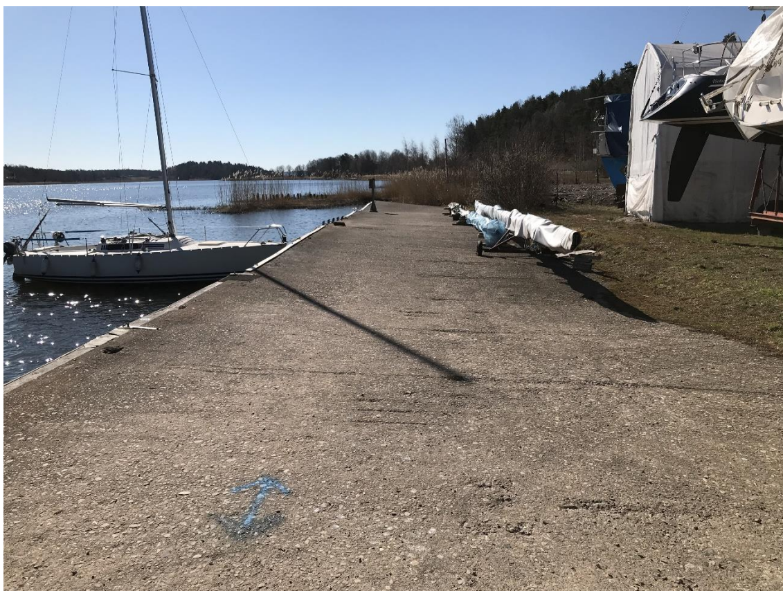
Figur 11. Den södra kajen vid sektion F.
